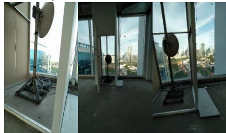
Gambar 3: Pemasangan Antenna di Tower B
